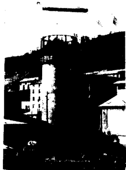
Final del 1 er silo 1.945.
