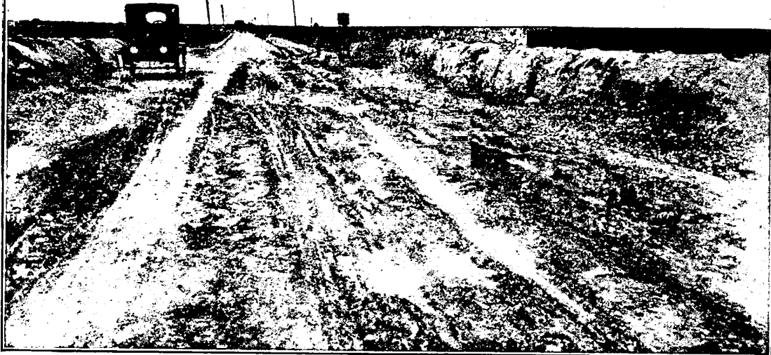
FIRME DE "MACADAM" A LOS SEIS MESES DE REPARADO
